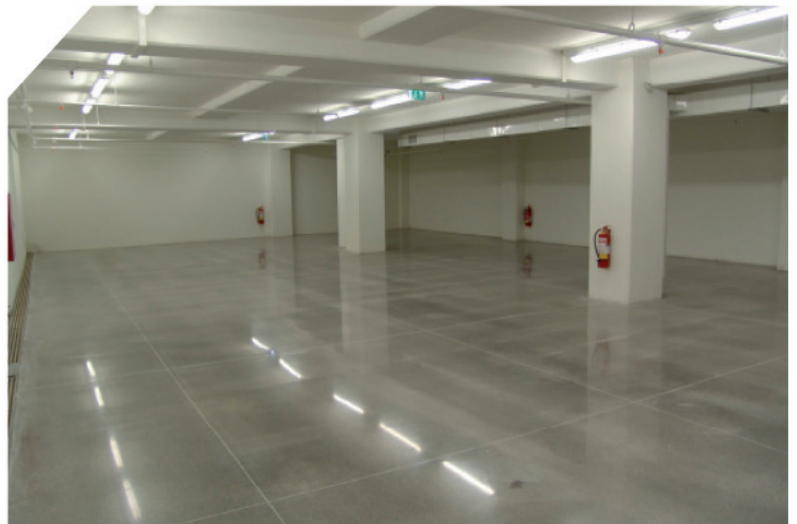
Sol béton poli dans parking souterrain
